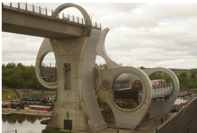
La roue de Falkirk (Falkirk Wheel) est un ascenseur à bateaux rotatif reliant le Forth and Clyde Canal à l'Union Canal. L'ascenseur a été inauguré par la reine Élisabeth II le 24 mai 2002 dans le cadre des célébrations de son Jubilé d'or. Cette « roue » est un modèle unique au monde qui permet d'élever les bateaux de 24 m. Les deux caissons, un montant et un descendant, sont larges de 6,5 m et peuvent contenir jusqu'à quatre péniches de 20 m de long.
