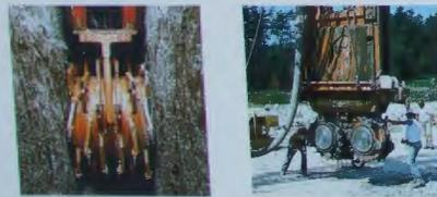
Mit der erstmals in Deutschland eingesetzten Hydrofräse kann die Dichtwand kontrolliert in den Untergrund eingebracht werden. Dabei wird ein Schlitz in das Gestein gefräst und dieser anschließend mit Beton verfüllt.
