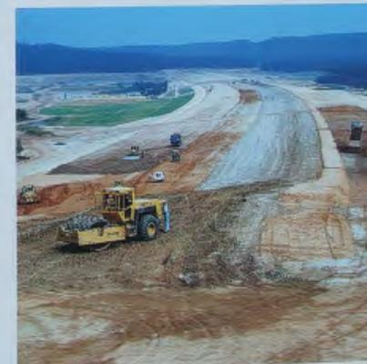
Der zonenweise Aufbau der Brombach-Hauptsperre spiegelt sich in den unterschiedlichen Farben des Schüttmaterials wieder. Insgesamt wurden 4 Mio. m<sup>3</sup> Erde bewegt.
