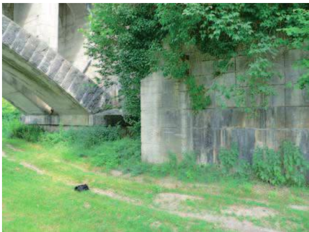
Repères d'inondation à St. Sorlin - en - Bugey
