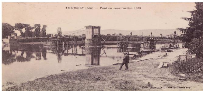
Ces deux images donnent une idée du chantier que représentait cette construction, avec tout l'art déployé pour monter les échafaudages et soutenir les coffrages du tablier et des arches en rivière, ainsi que des arcs qui font la particularité de cet ouvrage.
